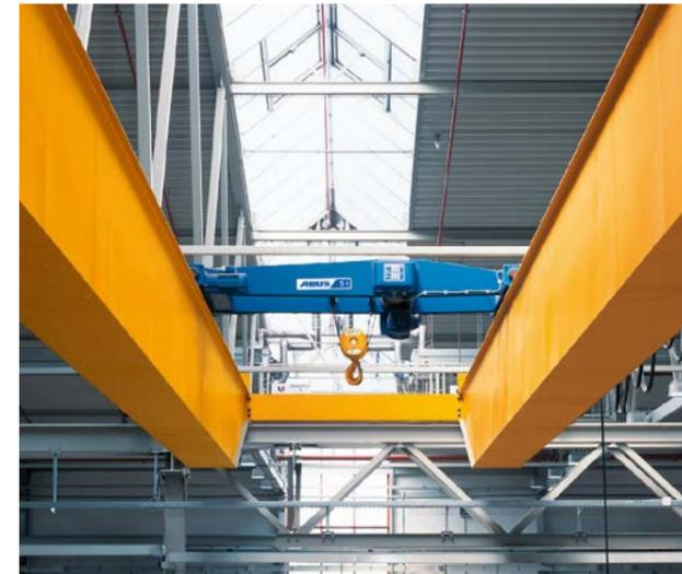
Opción de operativa con doble polipasto para el transporte de cargas particularmente pesadas y voluminosas. Los polipastos de cable se controlan desde el mando de la grúa de forma individual o sincronizados conjuntamente, a elección. Una importante mejora de la seguridad en el traslado de cargas.
