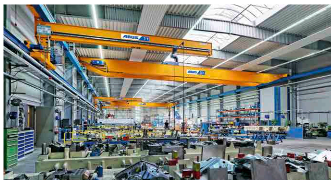
Montaje final en máquinas-herramienta
