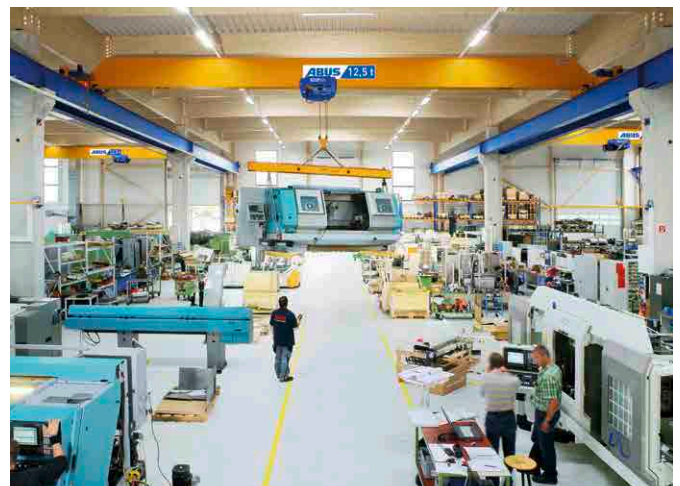
Trabajos seguros con cargas pesadas.
